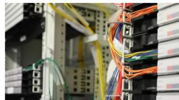
Raccordements terminés fin 2021 Pour assurer toute la couverture de Dangé-Saint-Romain et d'une petite partie des Ormes, d'Ingrandes-sur-Vienne et de Vaux-sur-Vienne, sept zones ont été établies, chacune raccordées à un nœud de raccordement optique permettant le branchement de 4.500 lignes. Chaque zone possède une armoire de rue pouvant accueillir 300 à 400 lignes et c'est de là que seront branchés les boîtiers extérieurs de raccordement.
